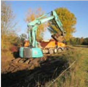
Erste Mulde mit Verbindungskanal ausheben
