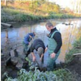
Aufbauen der Steine um den Wasserdruck abzufangen
