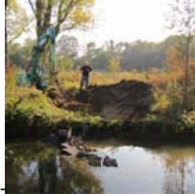
Zweite Mulde mit Verbindungskanal ausheben
