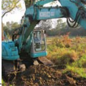
Zweite Mulde mit Verbindungskanal ausheben
