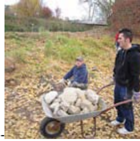
Steine in den Stichkanälen anfahren und verlegen
