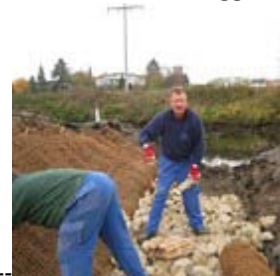
Steine in den Stichkanälen anfahren und verlegen
