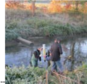
Einschlagen der Stahlrohre
