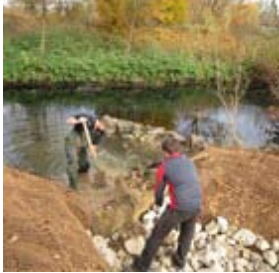
Steine in den Stichkanälen anfahren und verlegen
