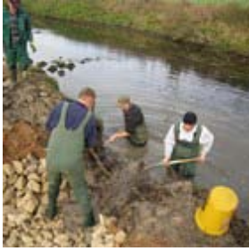
Der Damm wird weggeschaufelt
