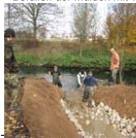
Der Damm wird weggeschaufelt
